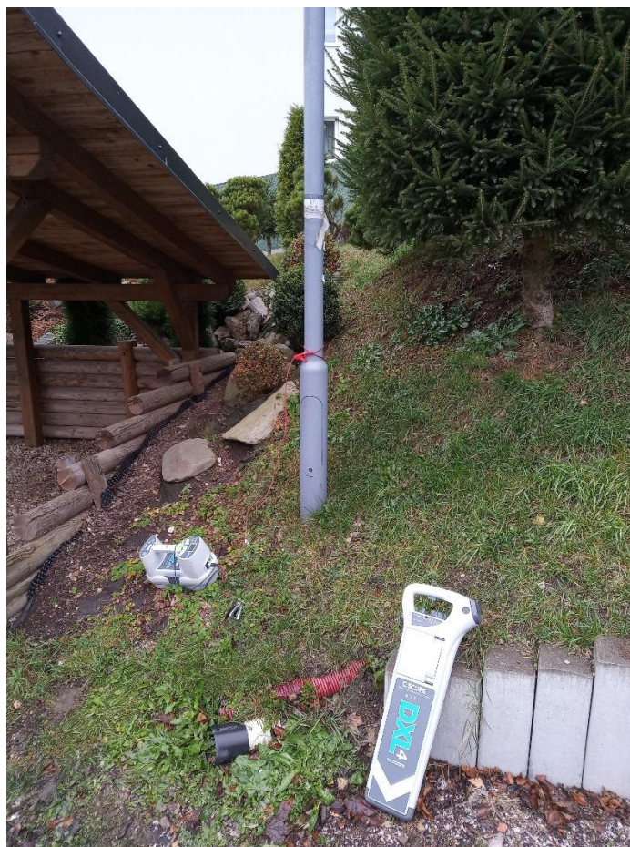
Obr. 22 Měření kabeláže v terénu
