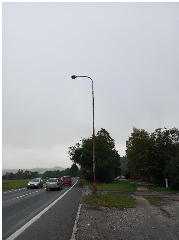
Obr. 23 Koroze stožáru
