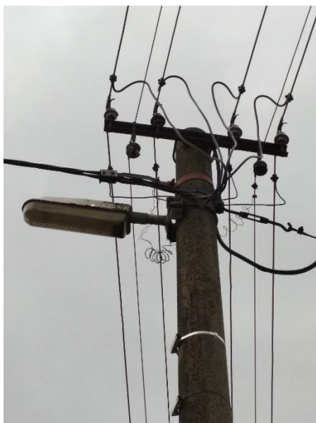
Obr. 19 Svítidlo se stavem 4 - uspokojivý
