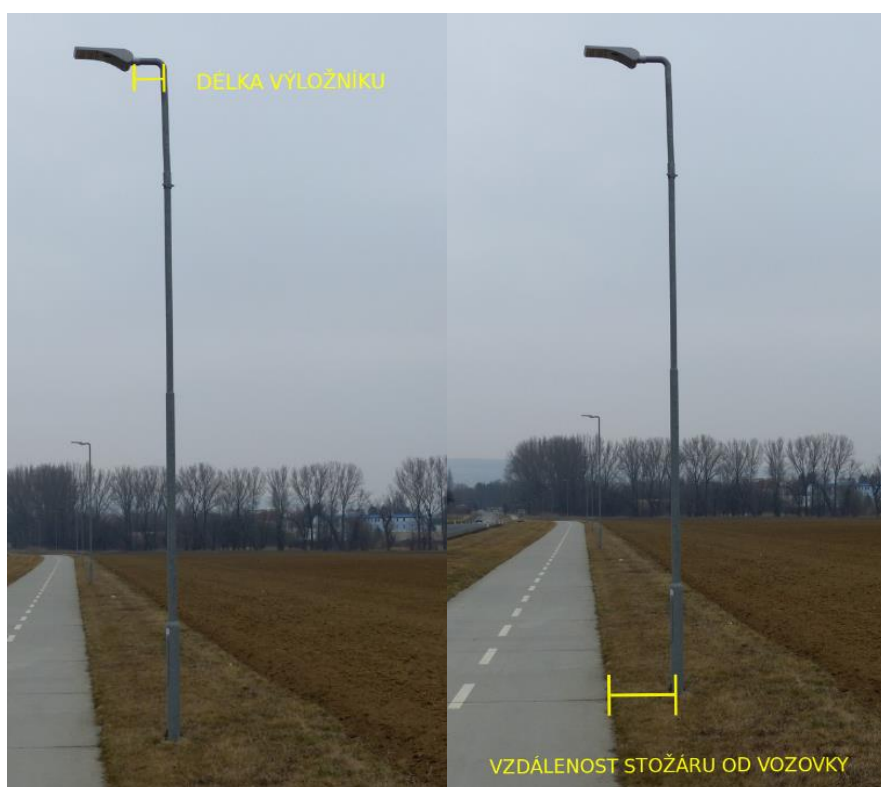
Obr. 2 Určování rozměrů světelného bodu – délka výložníku a vzdálenost stožáru od vozovky
