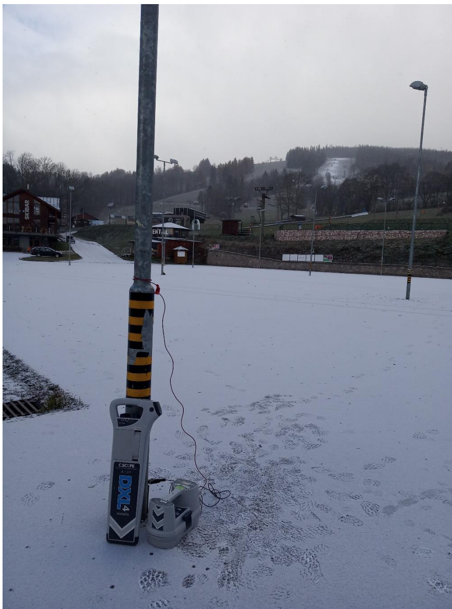
Obr. 19 Trasování zemní kabeláže v terénu
