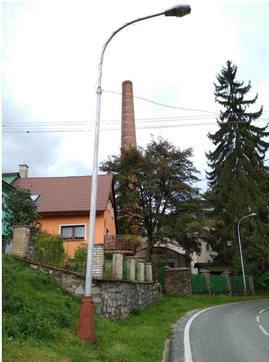
Obr. 17 Příklad vyosení stožáru SB (SB 6.25)
