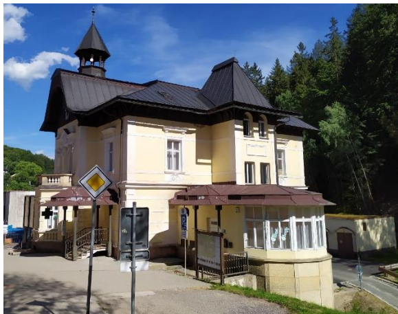
Obrázek 17: Budova s č. p. 85 – stav k červenci 2020
