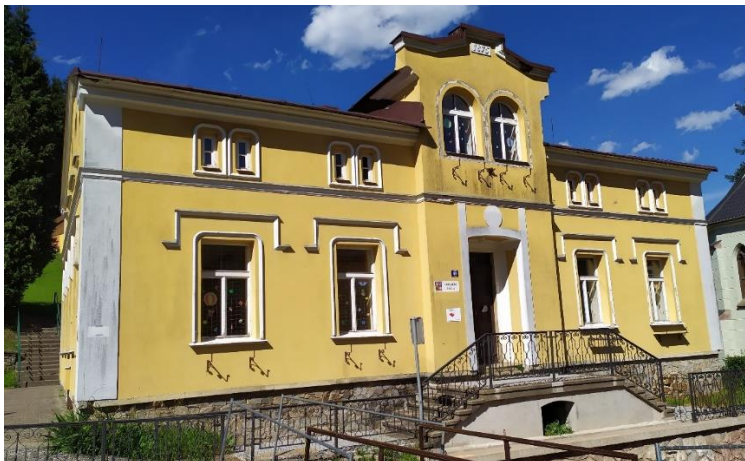
Obrázek 15: Budova s č. p. 68 – stav k červenci 2020
