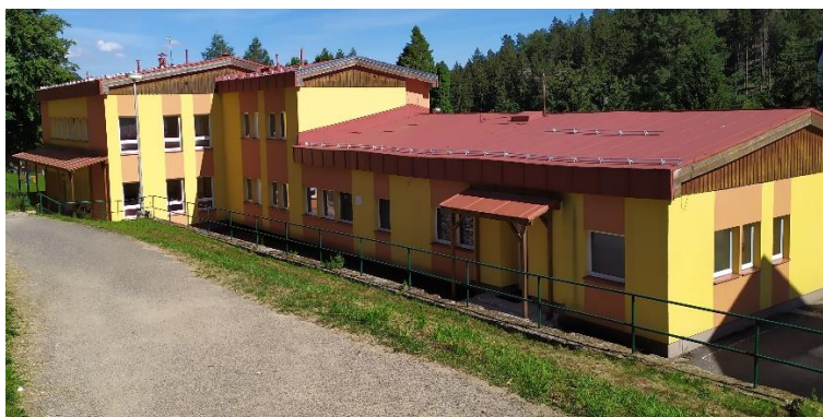
Obrázek 18: Budova s č. p. 251 – stav k červenci 2020
