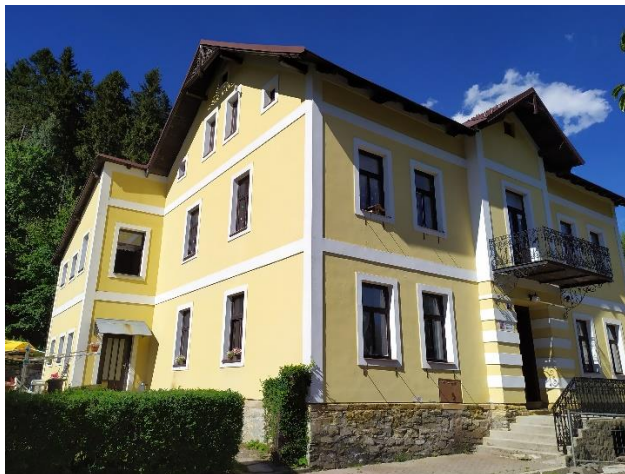
Obrázek 16: Budova s č. p. 81 – stav k červenci 2020
