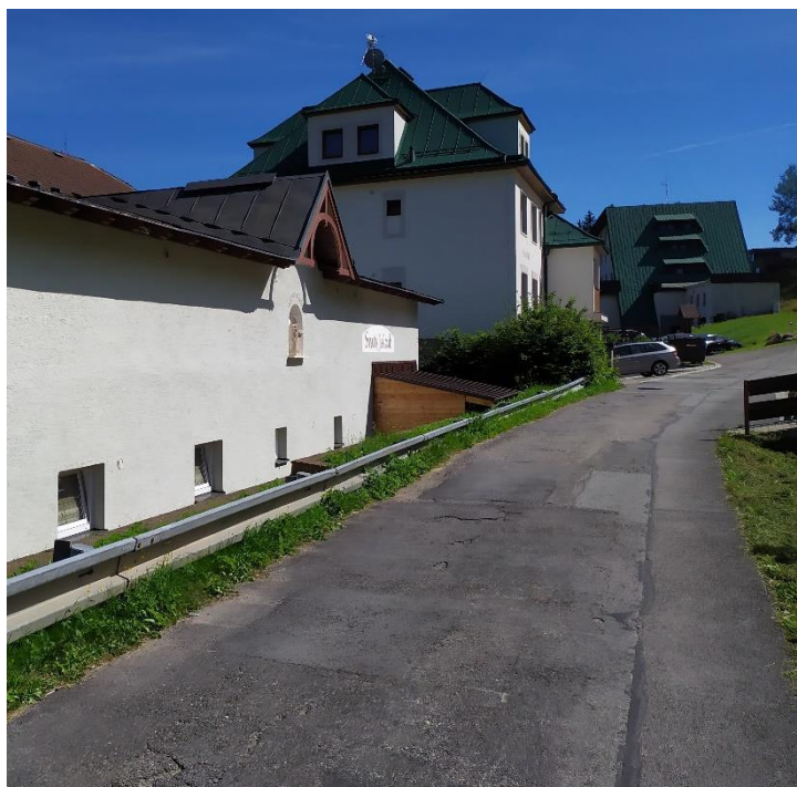
Obrázek 19: Modrokamenná ulice – stav k červenci 2020
