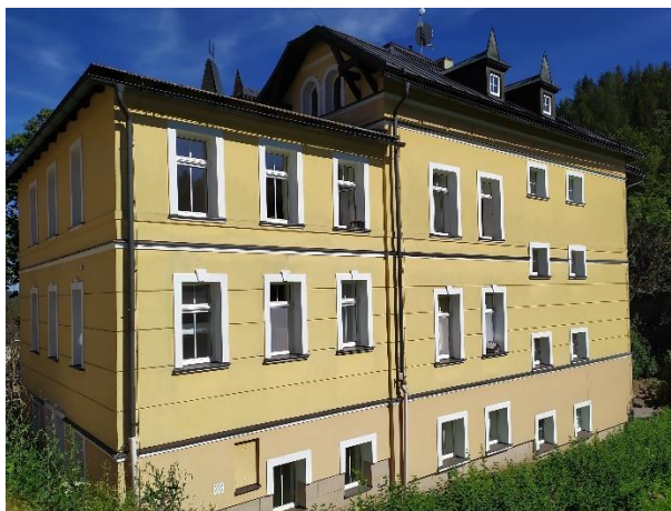
Obrázek 14: Budova s č. p. 15 – stav k červenci 2020
