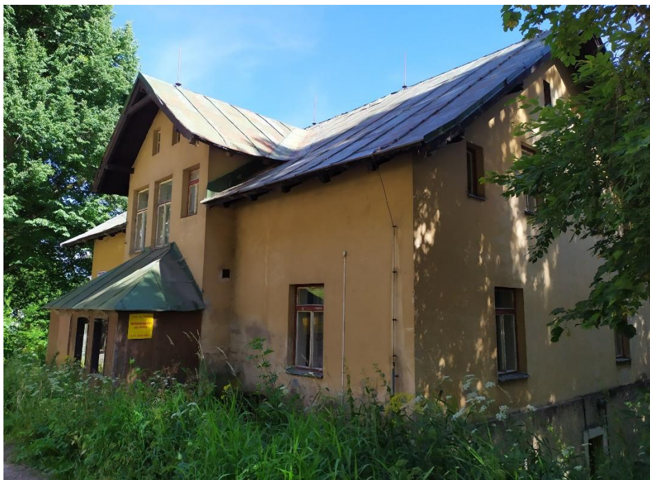
Obrázek 24: Budova s č. p. 19 – stav k červenci 2020
