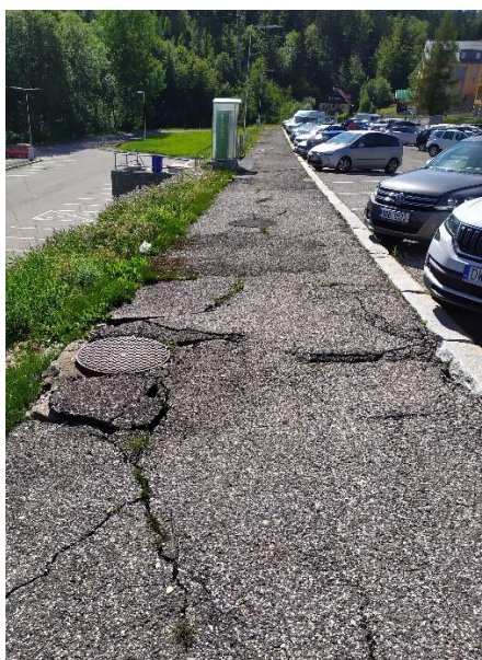
Obrázek 20: Chodník na centrálním parkovišti – stav k červenci 2020
