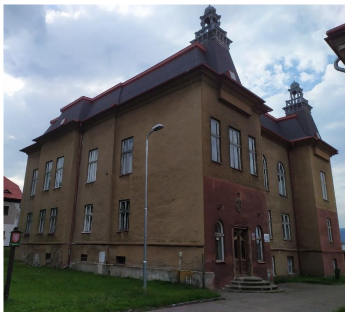
Obrázek 9: Budova ZUŠ – stav k srpnu 2020
