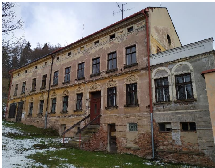
Obrázek 21: Budova s č. p. 90 v Rýchorské ulici – stav k dubnu 2021
