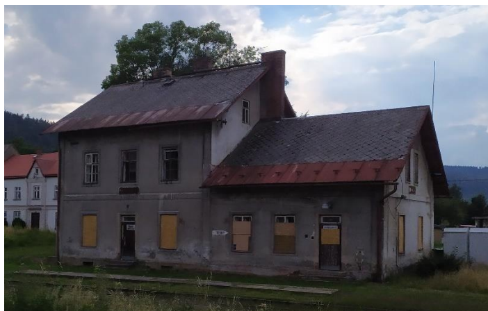
Obrázek 22: Budova v Nádražní ulici s č. p. 201 – stav k srpnu 2020
