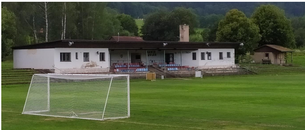
Obrázek 23: Zázemí fotbalového hřiště – stav k srpnu 2020
