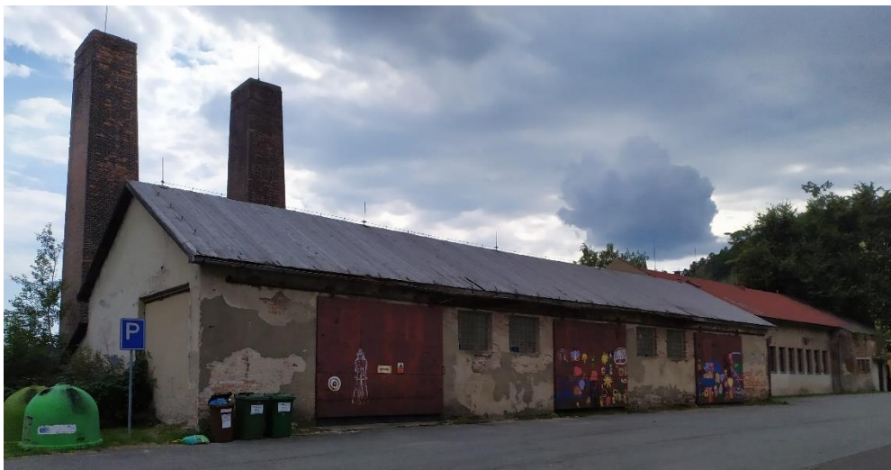
Obrázek 19: Objekt bývalé kotelny v ulici Na Pilíři – stav k srpnu 2020
