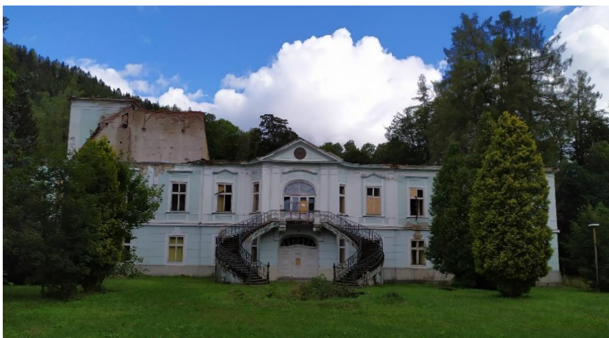
Obrázek 17: Objekt zámku – stav k září 2020
