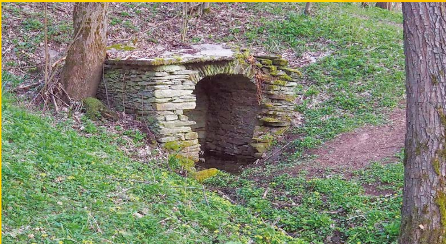
Dědičná štola odvodňovala zlaté doly.
